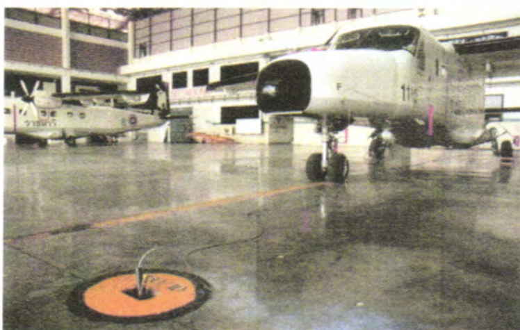
ภาพที่ ๕ การต่อสายดิน
